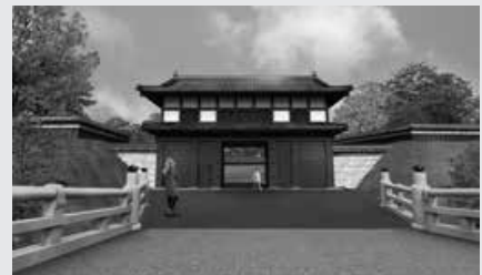
水戸城大手門工事概要：木造2階建て 建築面積約158.2㎡、高さ約13.3m、桁行約17.1m、梁間約5.7m、整備費約6億2千400万円
